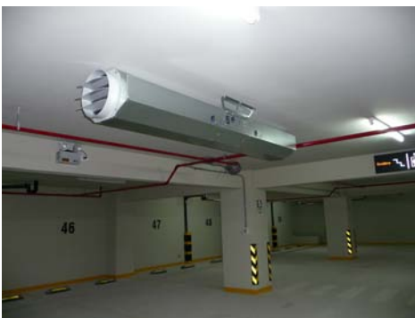
Parking installation Instalación en parking
